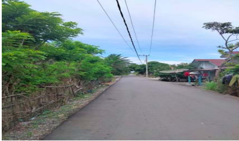
Akses jalan menuju Pantai Lhok Raja yang sudah di perbaiki
