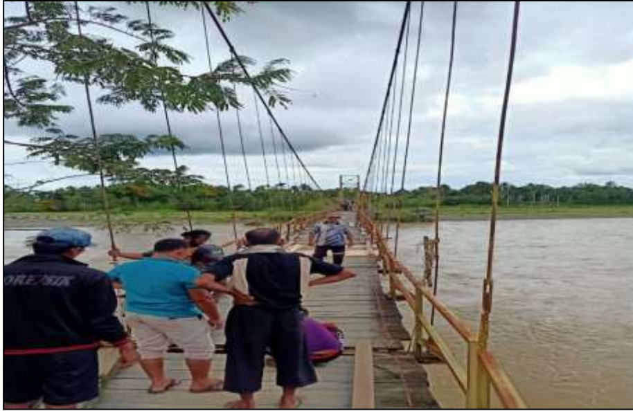
Jembatan Penghubung Gampong Kandeh dengan Gampong lain
