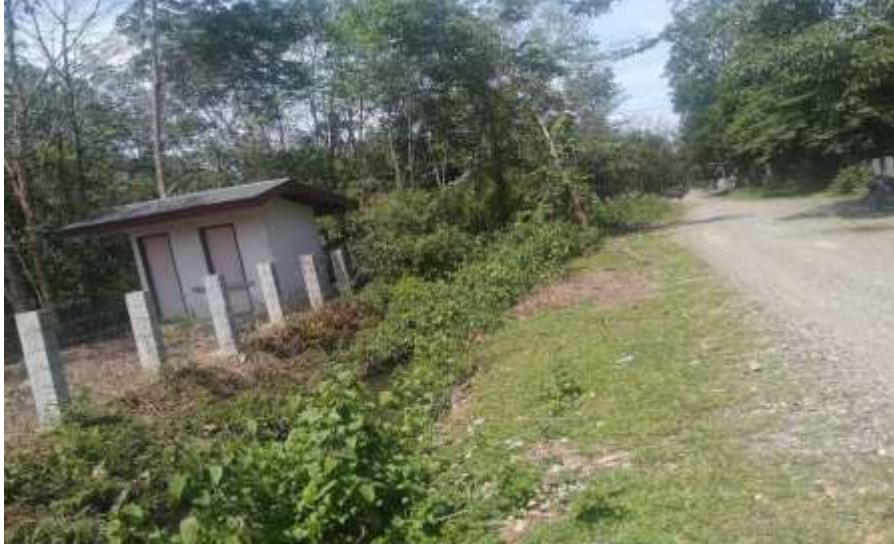
Pembangunan WC Umum Gampong Kandeh
