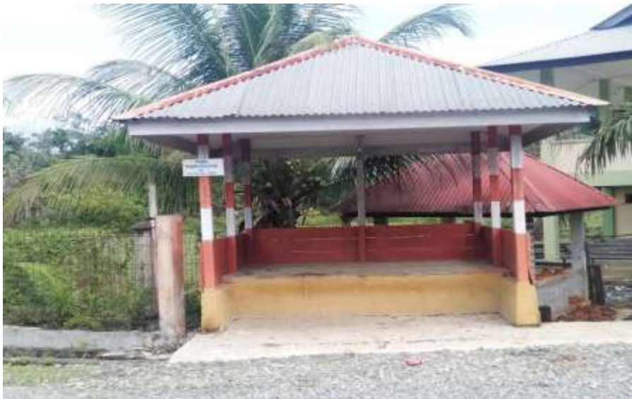
Pembangunan Pos Jaga Gampong Kandeh
