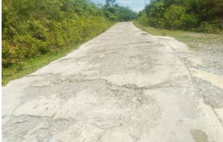
Pembangunan Rabat Beton Gampong Kandeh
