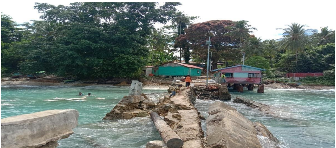
Gambar 7. Dokumentasi Kondisi Dermaga Pulau Siumat
