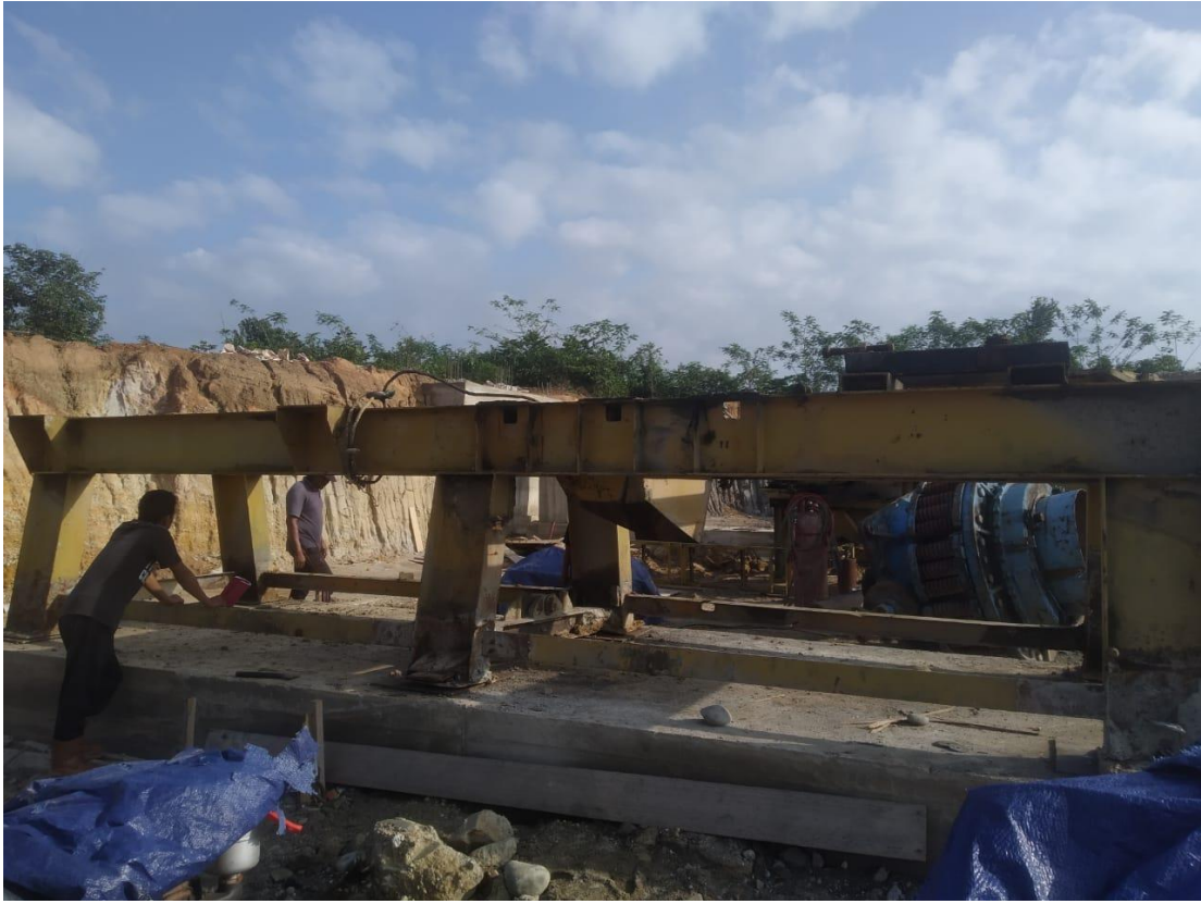
Pemasangan Jaw Crusher di Subulussalam
