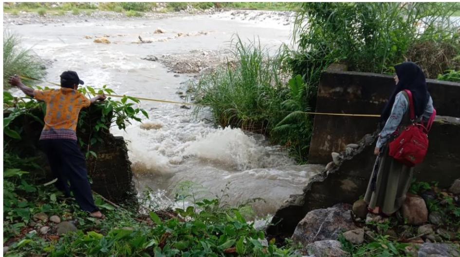
**Gambar 4.1 Kondisi dinding saluran Pembuang**
