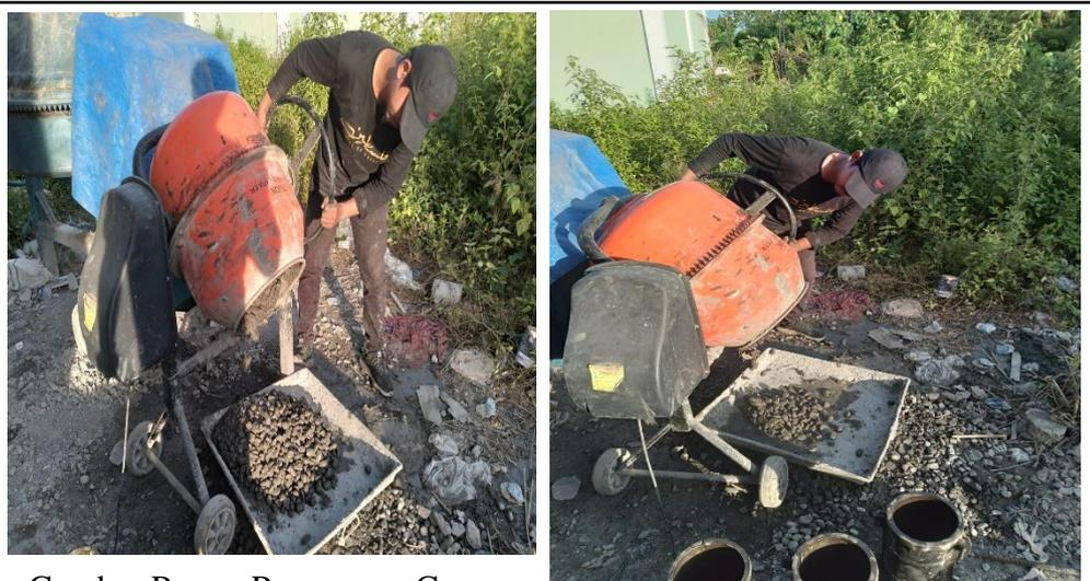
Gambar Proses Penuangan Campuran Beton kedalam Cetakan Silinder
