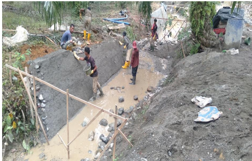
Gambar 3.2 Proses Pekerjaan Pasangan Batu Mortar
