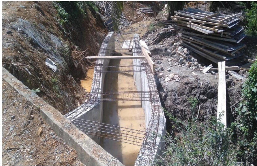
Gambar 3.5 Proses Pekerjaan Pembesian (Dapat dilihat lebih jelas pada Lampiran A. D.I Gunung Reubo No.6)
