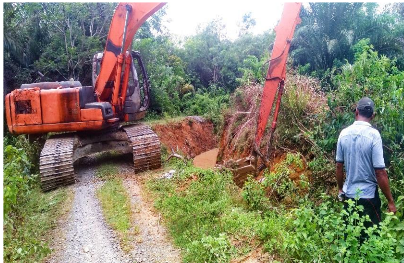
Gambar 3.1 Proses Pekerjaan Galian Tanah AB
