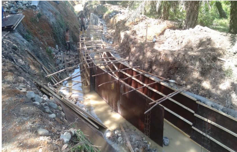
Gambar 3.6 Proses Pemasangan Bekisting
