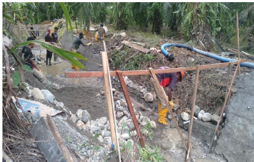
Gambar 3.3 Proses Pekerjaan Pasangan Batu Mortar (Dapat dilihat lebih jelas pada Lampiran A. D.I Gunong Reubo No.2)
