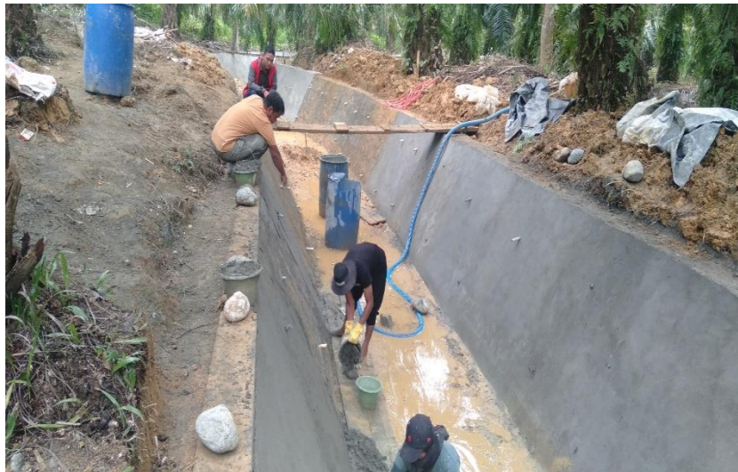
Gambar 3.4 Proses Pekerjaan Plasteran
