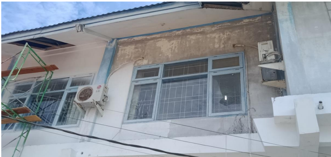
Gambar : A. 4.2 Kondisi Jendela Pada Bangunan Gedung Sumber : Dokumentasi Di Lapangan
