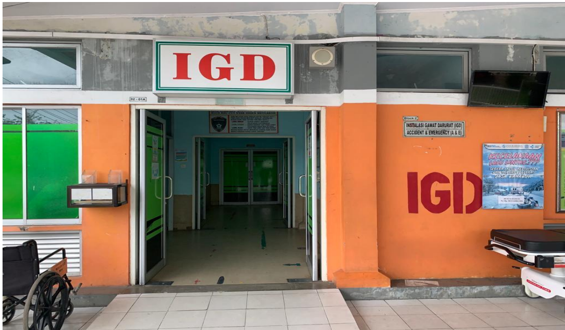
Gambar 1. Gambaran Depan Instalasi Gawat darurat RSUD Cut Nyak Dhien Meulaboh
