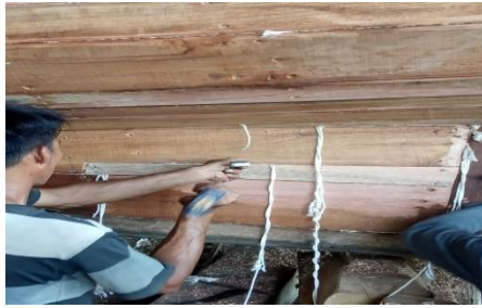
Pemakalan pori-pori sambungan papan
