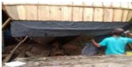
Pemasangan lapisan terpal plastik
