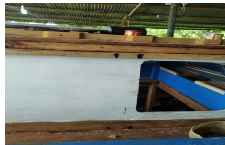
Pemasangan papan kamar mesin
