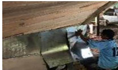
Pemasangan lapisan seng aluminium
