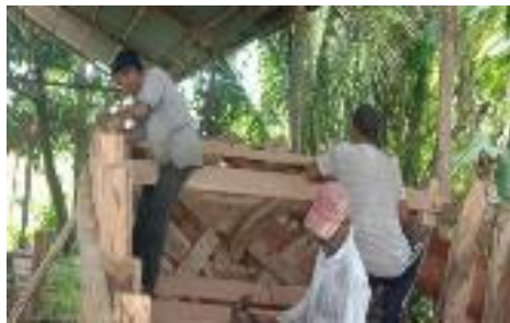
Pemasangan bantalan dek
