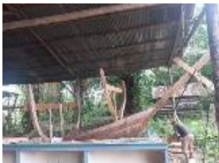
Pemasangan gading-gading dasar
