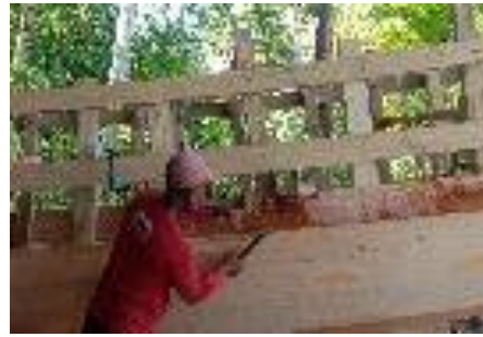
Pemasangan Papan lambung (lanjut)
