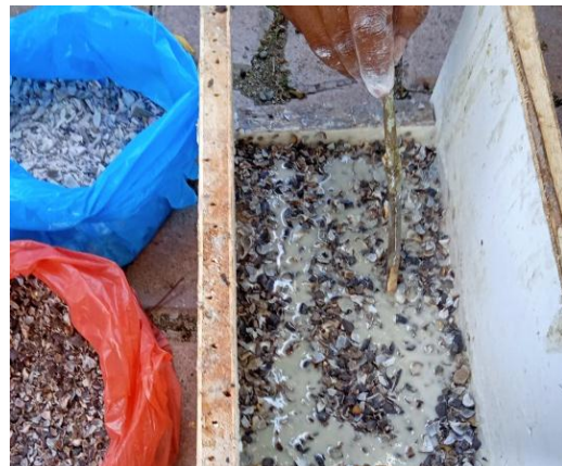
Sumber : Dokumentasi pribadi (b) Meratakan resin
