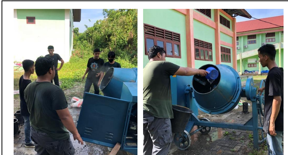
Gambar Penuangan Bahan dan Material kedalam Campuran Beton Sumber : Lapangan
