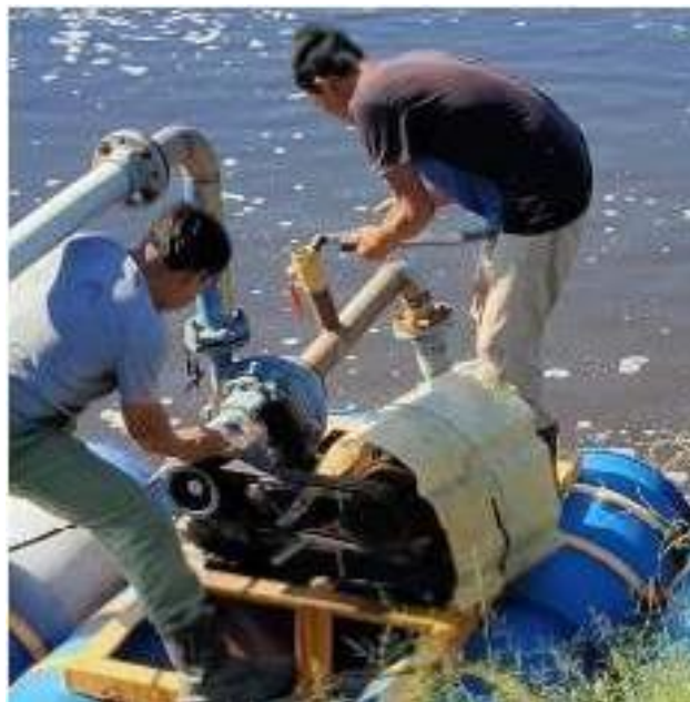
Memperbaiki Pompa Air Limbah
