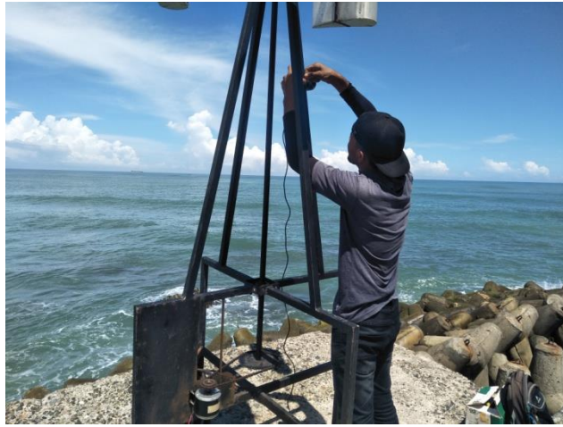
Gambar B.2 Pemasangan alat ukur anemometer (Sumber: Penelitian)
