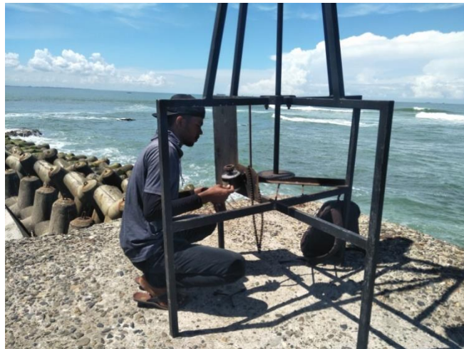
Gambar B.3 Pemasangan Generator pada turbin (Sumber: Penelitian)
