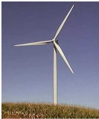
Gambar 2.2 Turbin Angin Sumbu Horizontal
