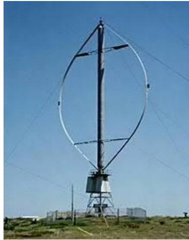
Gambar 2.3 Turbin Angin Sumbu Vertikal
