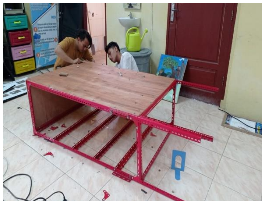
Gambar 3. Proses pemasangan dinding alat pengering
