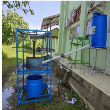
Gambar 4.9 Instalasi Turbin Air (Sumber : Penelitian 2022)
