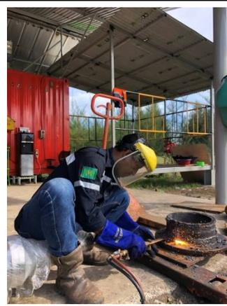
Proses Perbaikan dan Pemeliharaan pada *Belt Conveyor*
