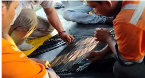
Gambar: 2.7 Penyambungan Belt Conveyor
