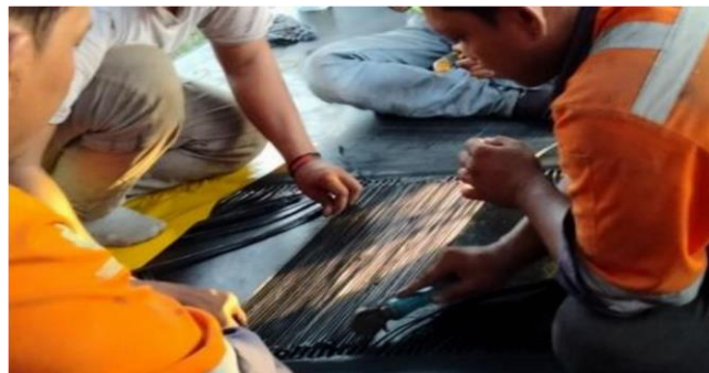
Gambar 9. Proses Penyambungan Belt Conveyor
