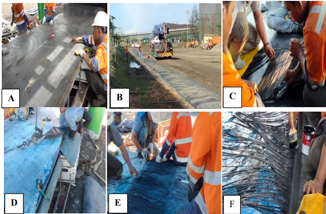
Gambar 3.1 Jenis Tahap-tahap proses replace belt conveyor
