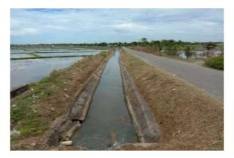
7. Pada Ruas BKL.3 - BSM.1 terdapat kerusakan saluran (sekunder), pada saluran ini mengalami kerusakan sepanjang 110 meter, dengan panjang saluran 630,90 meter.
