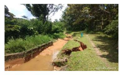
4. Pada Ruas BMG. 3 - BMG. 4 terdapat kerusakan saluran (sekunder), pada saluran ini mengalami kerusakan sepanjang 33 meter, dengan panjang saluran 885 meter.
