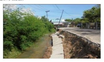
6. Pada Ruas BAL.1 - BAL.2 terdapat kerusakan saluran (sekunder), pada saluran ini mengalami kerusakan sepanjang 82 meter, dengan panjang saluran 737,25meter.
