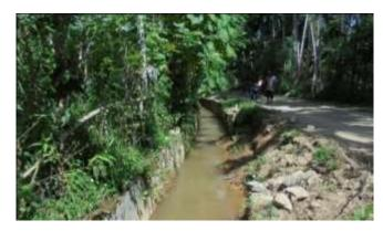
5. Pada Ruas BSM.1 - BSM.2 terdapat kerusakan saluran (sekunder), pada saluran ini mengalami kerusakan sepanjang 200 meter, dengan panjang saluran 2.078 meter.
