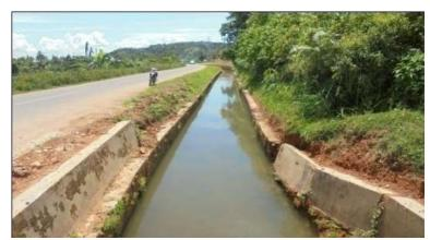
2. Pada ruas BAL.4 - BAL.5 terdapat kerusakan saluran (sekunder), pada saluran ini mengalami kerusakan sepanjang 42 meter, dengan panjang saluran 1.664,80 meter.
