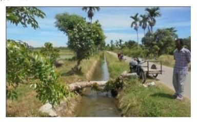
3. Pada ruas BMG. 2 - BMG. 3 terdapat kerusakan saluran (sekunder), pada saluran ini mengalami kerusakan sepanjang 165 meter, dengan panjang saluran 1.894 meter.
