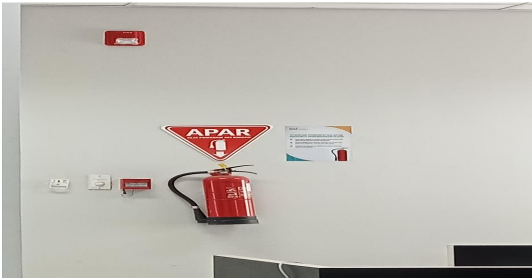
Gambar A.4.10 : Alat Pemicu Alarm Manual dan APAR
