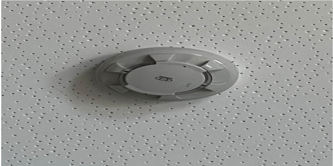
Gambar A.4.9 : Detektor Asap dan Panas
