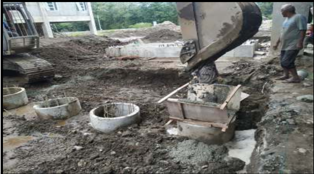
Gambar A. 7 : Proses Pembangunan R.S. Regional Cut Nyak Dhien Sumber : Pengambilan Dokumentasi di Lapangan, 2022.
