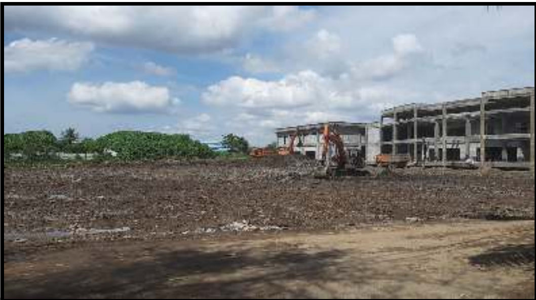
Gambar A. 6 : Proses Pembangunan R.S. Regional Cut Nyak Dhien Sumber : Pengambilan Dokumentasi di Lapangan, 2022.
