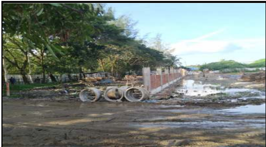
Gambar A. 8 : Proses Pembangunan R.S. Regional Cut Nyak Dhien Sumber : Pengambilan Dokumentasi di Lapangan, 2022.
