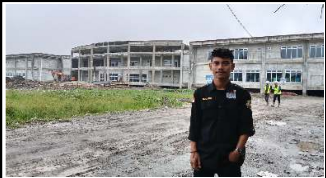
Gambar A. 17 : Proses Pembangunan R.S. Regional Cut Nyak Dhien Sumber : Pembagian Kuesinor Kepada Responden (2022)
