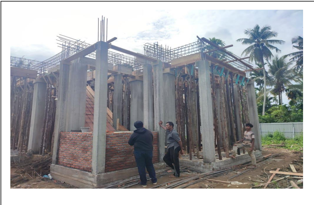
Gambar A.4. 3: Pekerjaan di Lapangan
