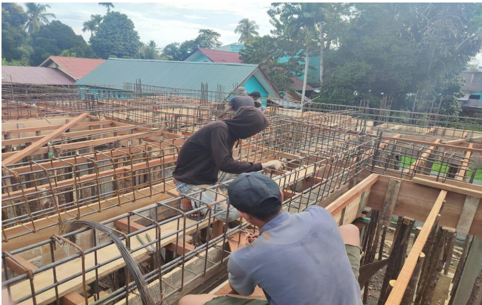
Gambar A.4. 5: Pekerjaan di Lapangan
