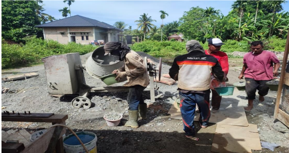
Gambar A.4. 6: Pekerjaan di Lapangan
