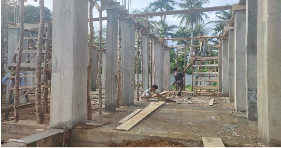
Gambar A.4. 4: Pekerjaan di Lapangan
