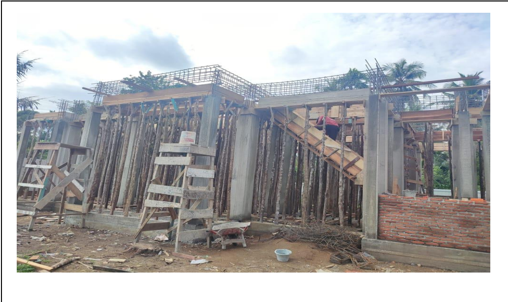
Gambar A.4. 2: Pekerjaan di Lapangan
