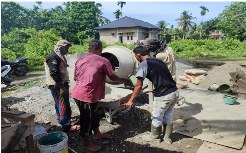
Gambar A.4. 7: Pekerjaan di Lapangan
