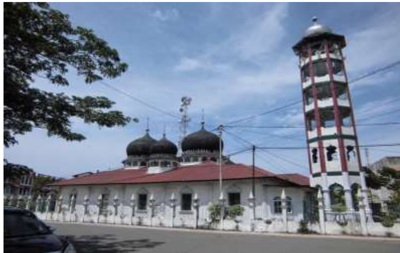
Gambar 4. Kondisi Masjid Nurul Huda di Aceh Barat
