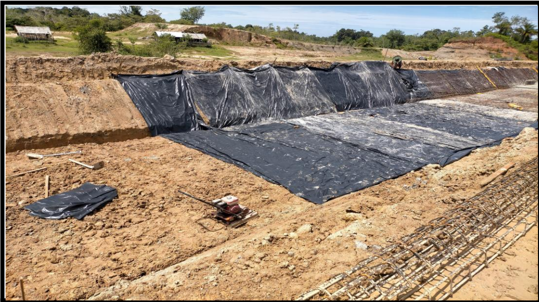
Gambar C.1 : Dokumentasi Pengerjaan Jaringan Irigasi Lhok Guci
