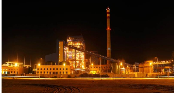
Gambar 3.1 PLTU Nagan Raya ( Sumber : PLTU Nagan Raya )
