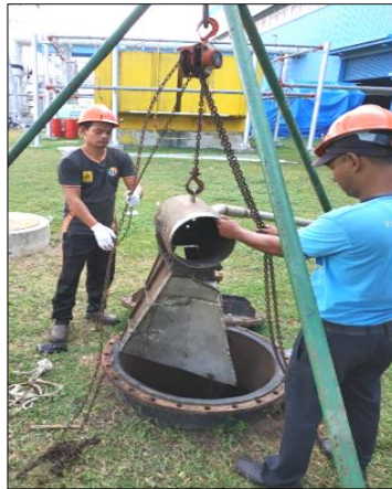
Gambar 3.12 Pemasangan Bucket ( Sumber : Penelitian.2021 )
