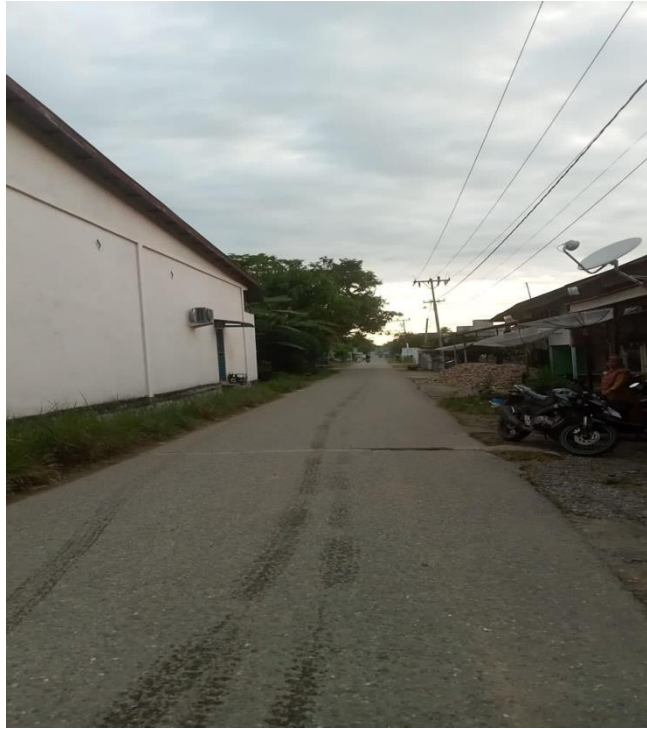
Infrastruktur Jalan di Desa Padang Sikabu
