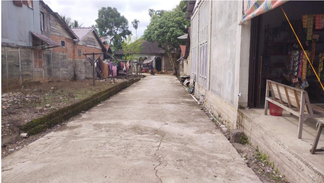
Infrastruktur Jalan Sitapak Dusun Cempaka di Desa Padang Sikabu
