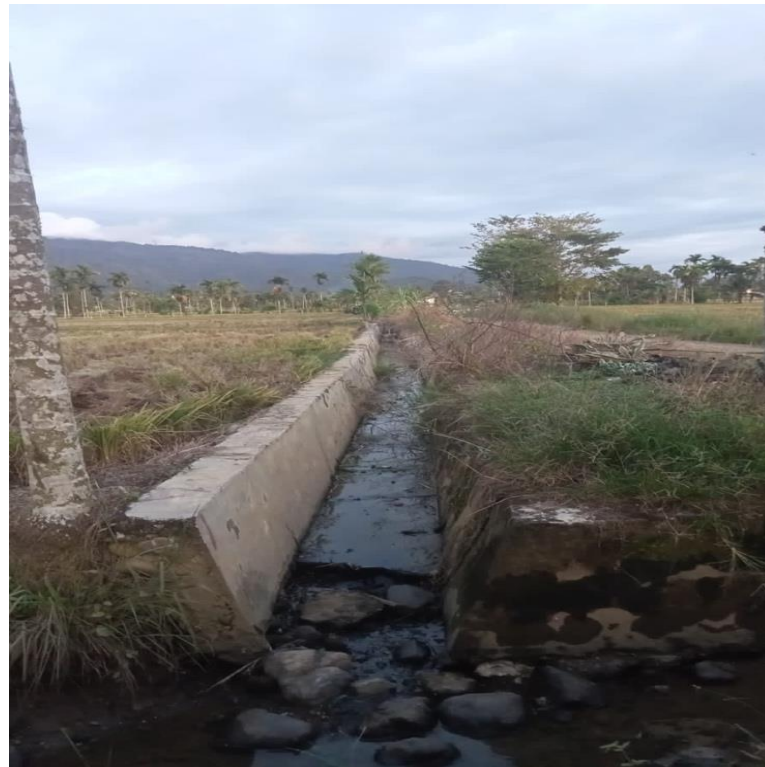
Infrastruktur Tanggul Perairan Sawah di Desa Padang Sikabu
